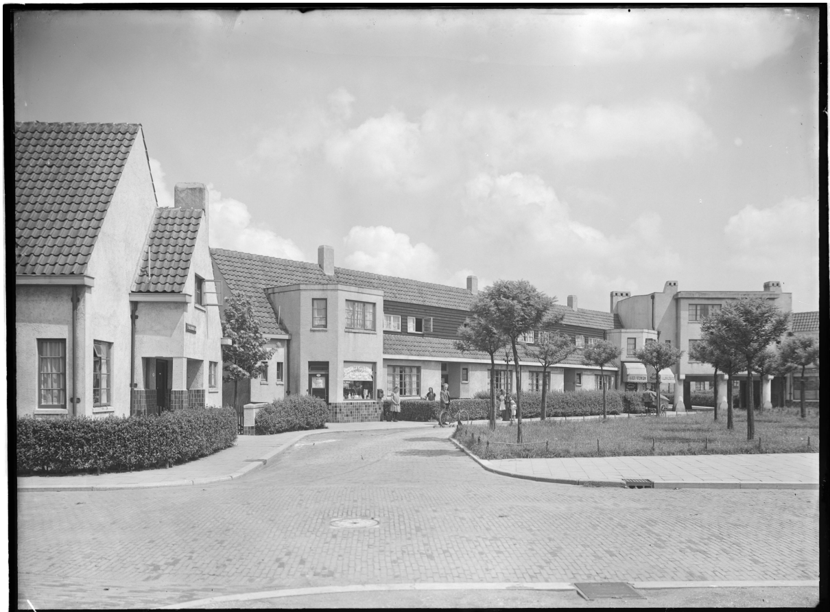
Van Ojen, E.M. (1923-1927), Zicht op de betonwoningen van Tuindorp De Kossel aan de 2e Balsemienstraat met een vestiging van stoomzuivelfabriek Aurore op nummer 33. Gemeente Rotterdam.
